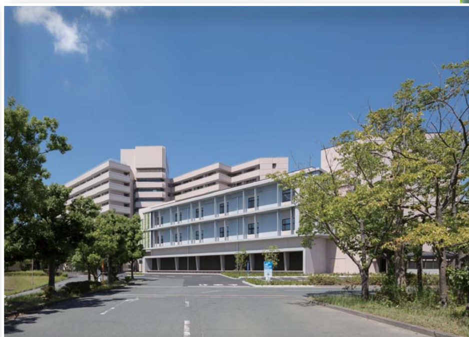
高度放射線棟（平成28年8月竣工）
