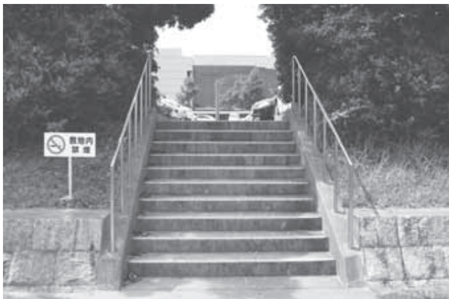
津波等の浸水対策として地面を高くしています
