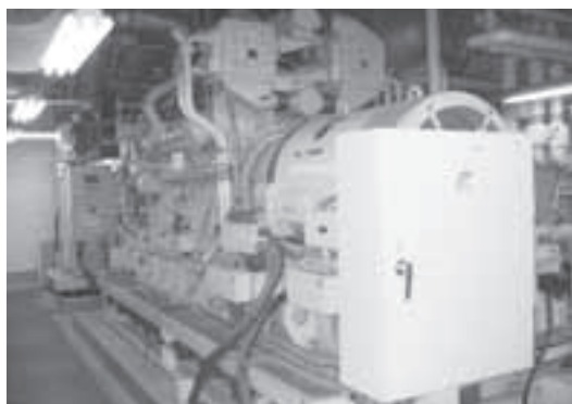
常用発電設備
